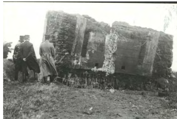
Ingeniørofficerer kontrollerer resultatet af deres sprængning af en bunker i 'Sikringsstilling Nord'.
