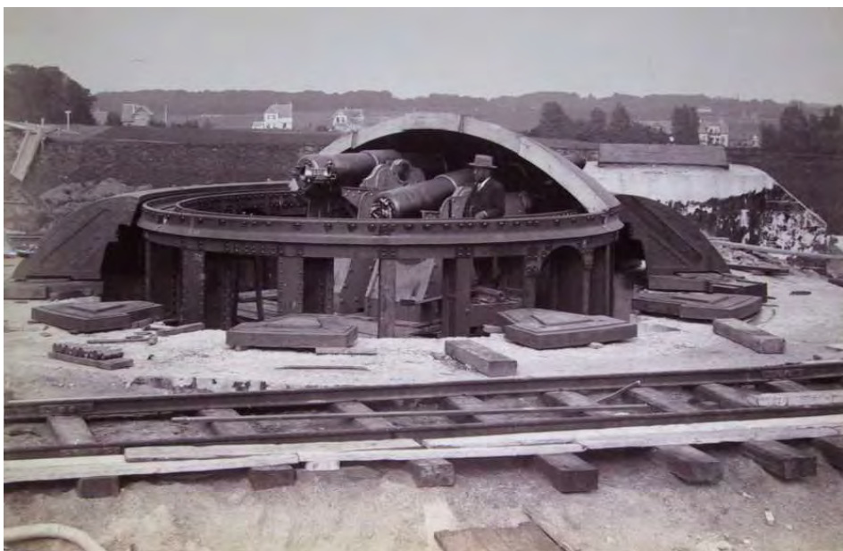
Fra byggeriet af Garderhøjfortet.
