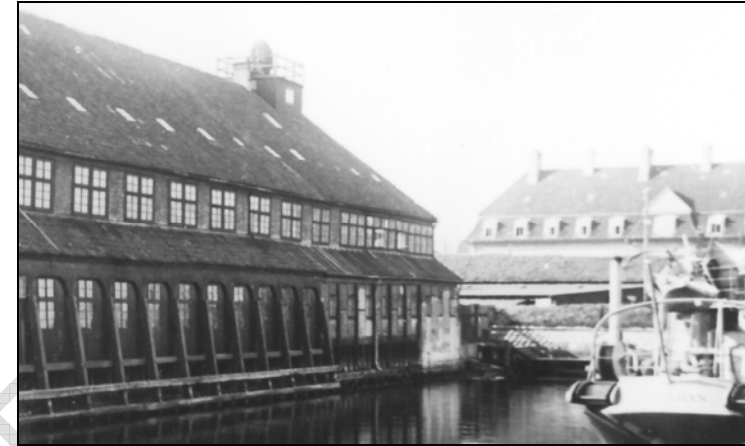
Projektørplatformen på Spalteloftsbygningen. Marinens Bibliotek.
